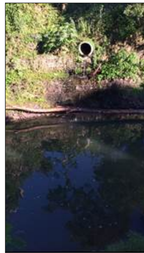
Figura 3: Descarga proveniente da drenagem pluvial no Arroio Hermes. Fonte: Autor.
